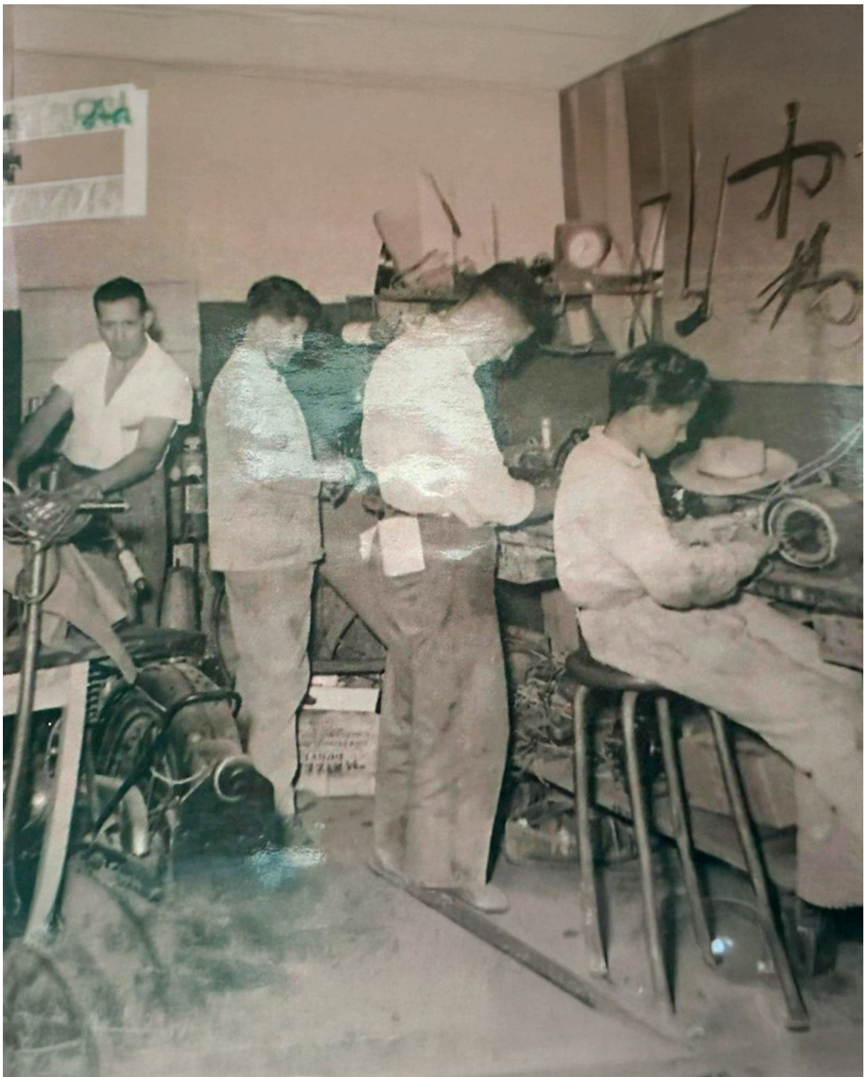
Oficina de manutenção de motores elétricos na Rua Primitiva Vianco, em Osasco, de propriedade de Carlos Christensen na década de 1940
